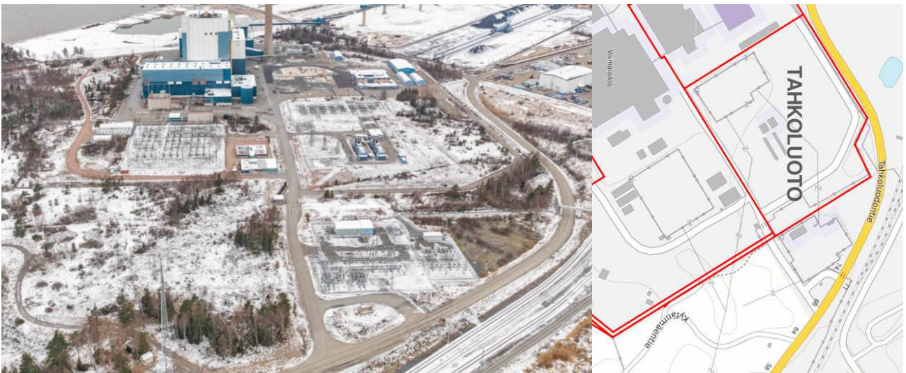
Fortumin ja Pori Energian sähköasemat ja niiltä lähtevä 400kV:n voimalinja. Sähköasemien laajenemisvara on noin 4 ha. Kuvat: Röni-Kuva 2023, Porin kaupunki, kiinteistörekisteri 2020.
