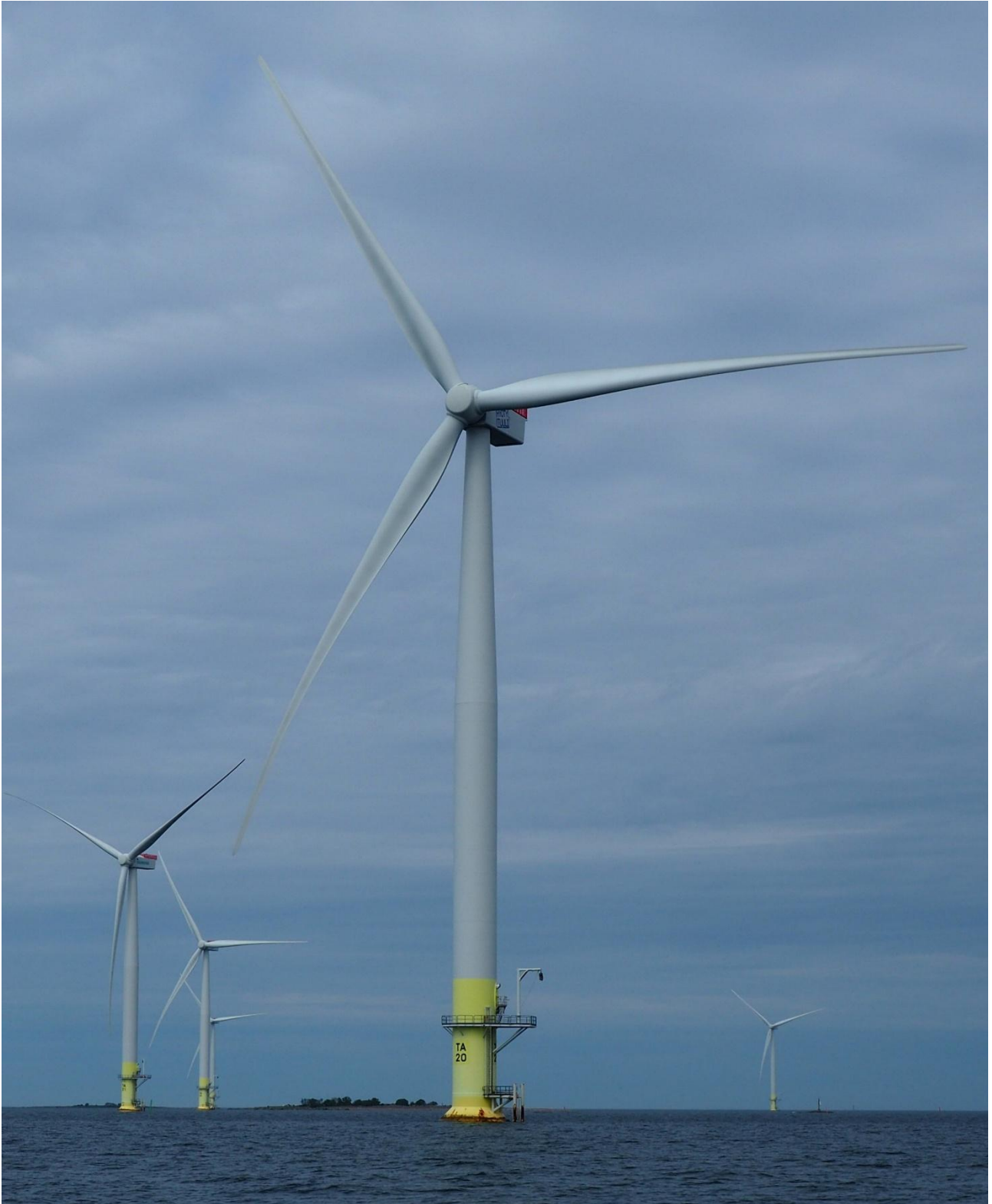
Tuulivoimalat ovat Tahkoluodon merimaiseman leimallinen elementti. Kuvassa mereentäyttöaluetta lähinnä olevia tuulivoimaloita Kaijakaran ympärillä. Tuulivoima-alueiden kehityksen suunnittelu ei kuitenkaan kuulu Tahkoluoto-Paakareiden osayleiskaavaan. Merituulivoima-alueet, tarvittavat merikaapelit ja voimalinjat suunnitellaan erillisissä osayleiskaavoissa ja YVA-prosesseissa. Kuva: M. Vuorenpää 2025.
