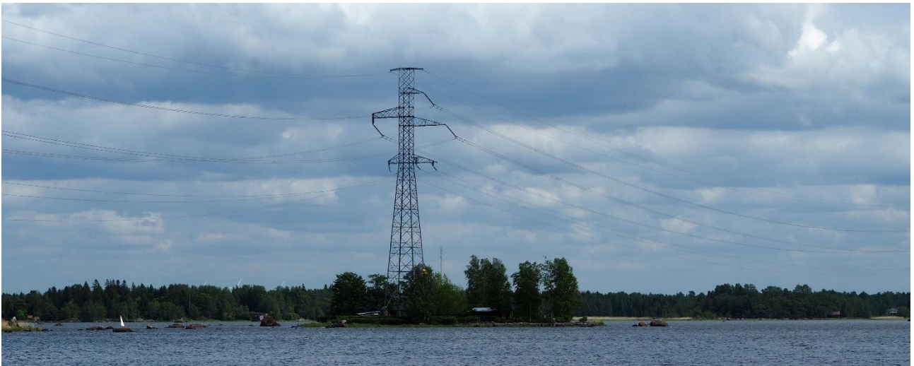
Kuvassa alueella kulkeva 400kV voimalinja. Kuva M. Vuorenpää 2025.
