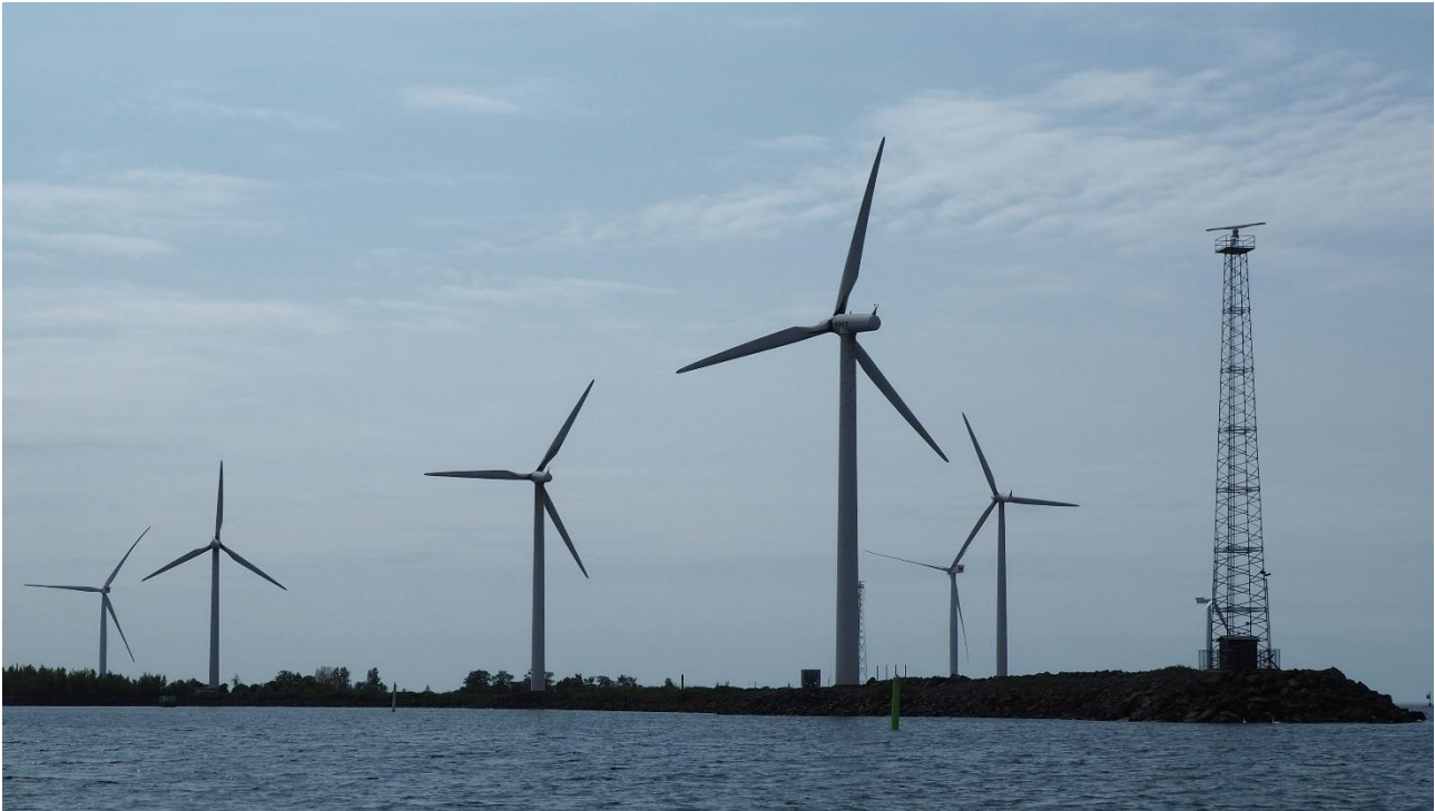
Sataman 2000-luvun vaihteessa rakennetut tuulivoimalat ovat nykyiseen tuulivoimalatekniikkaan verrattuna yli kaksi kertaa pienempiä. Uudet tuulivoimalat eivät sovellu kehittyvän kemianteollisuussataman alueelle. Kuva: M. Vuorenpää 2025
